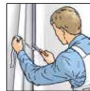
**5.** Dans les coins et sur les arêtes, découper le lé et tapisser le lé suivant bord à bord à joints vifs.
