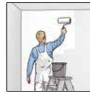
**3a.** Pour les supports lisses et ceux légèrement structurés, enduire largement les lés un par un avec le système de collage ERFURT-SR 2 en utilisant un rouleau à longs poils.
