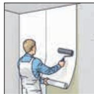
**4.** Éliminer les bulles d'air et les plis à l'aide d'une brosse de tapissier ou d'un rouleau en caoutchouc.
